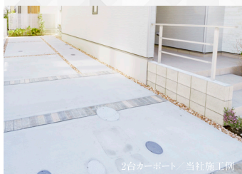
2台カーポート／当社施工例
