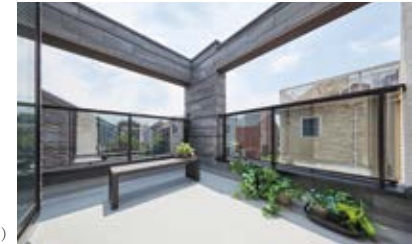
大型バルコニー (施工例)
